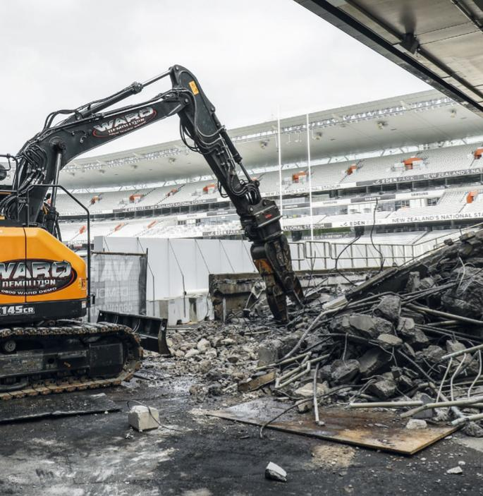
À medida que o multifunção demolia e reduzia a estrutura em cimento, a multi grab liberava o campo e carregava os resíduos de demolição nos caminhões.
