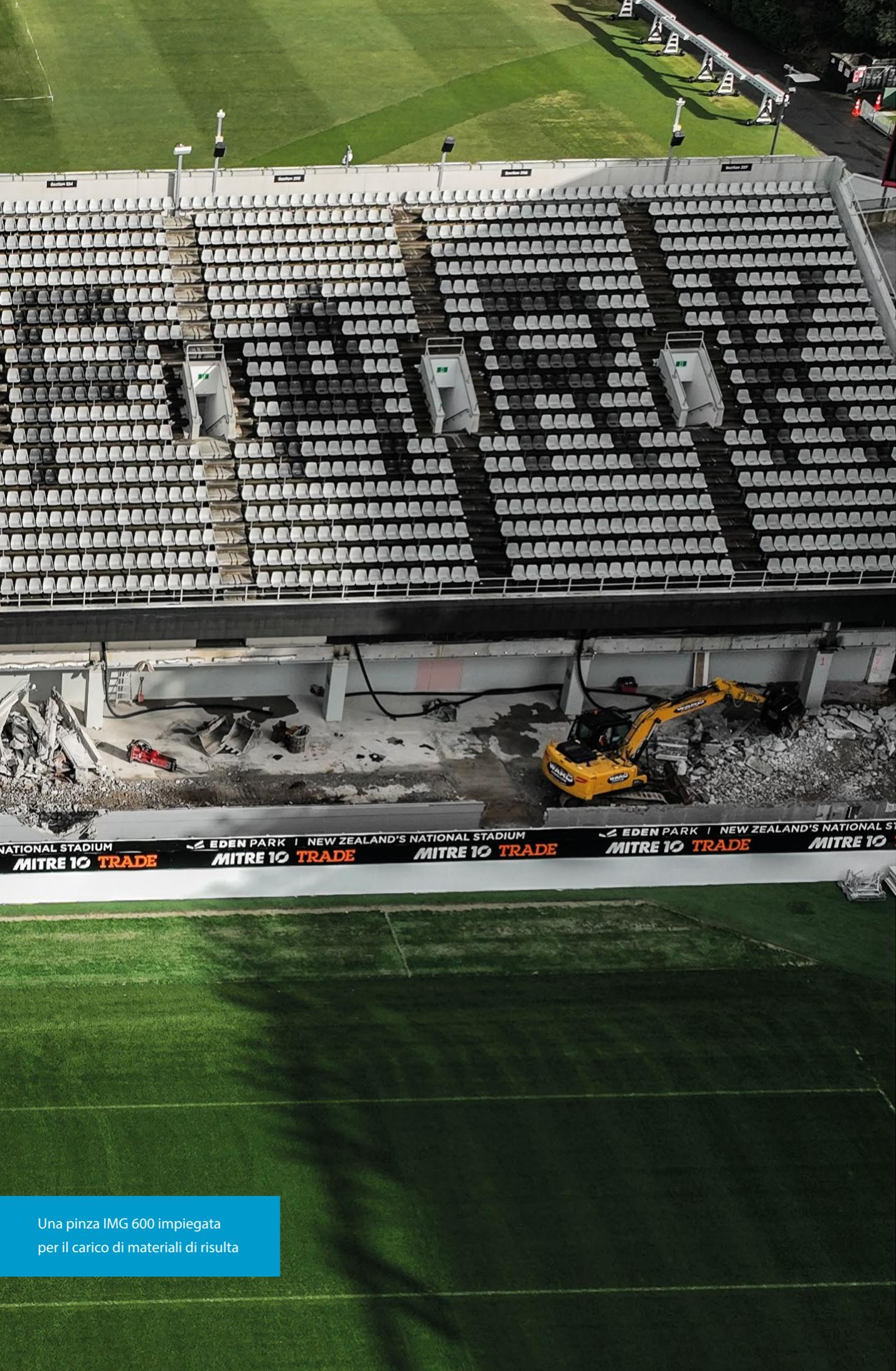
Una pinza IMG 600 impiegata per il carico di materiali di risulta
