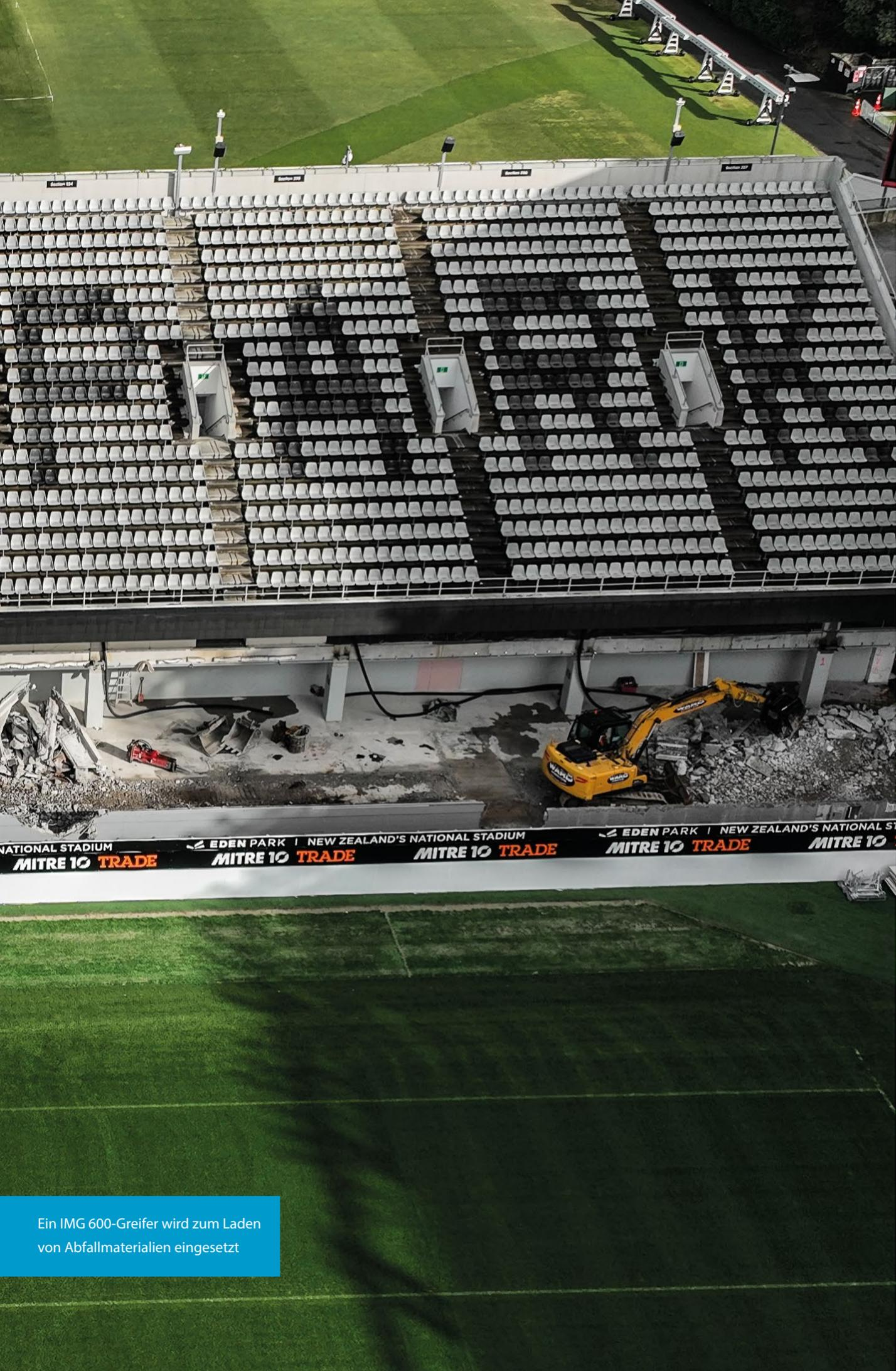
Ein IMG 600-Greifer wird zum Laden von Abfallmaterialien eingesetzt
