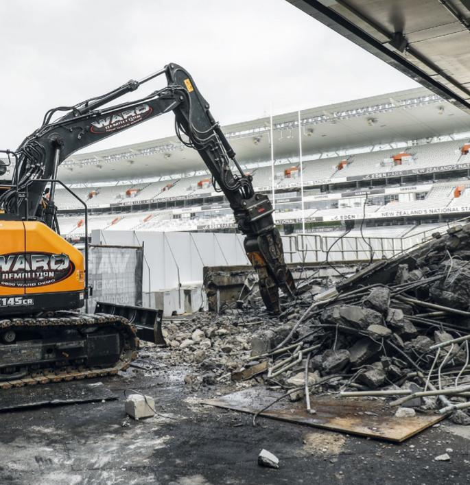
der Greifer Multi Grab das Feld und lud die Abbruchmaterialien auf die Lastwagen. Der IMP 15-Multifunktionsgerät ermöglichte es außerdem, auch in der Nähe der Großbildleinwand mit höchster Präzision und Sicherheit zu arbeiten und den Abbruch des umliegenden Betons abzuschließen, ohne den Träger zu beschädigen. Ward Demolition ist sehr zufrieden mit der Qualität und Effizienz der Indeco-Produkte und dem Kundendienst unseres Händlers Crush & Screen.
