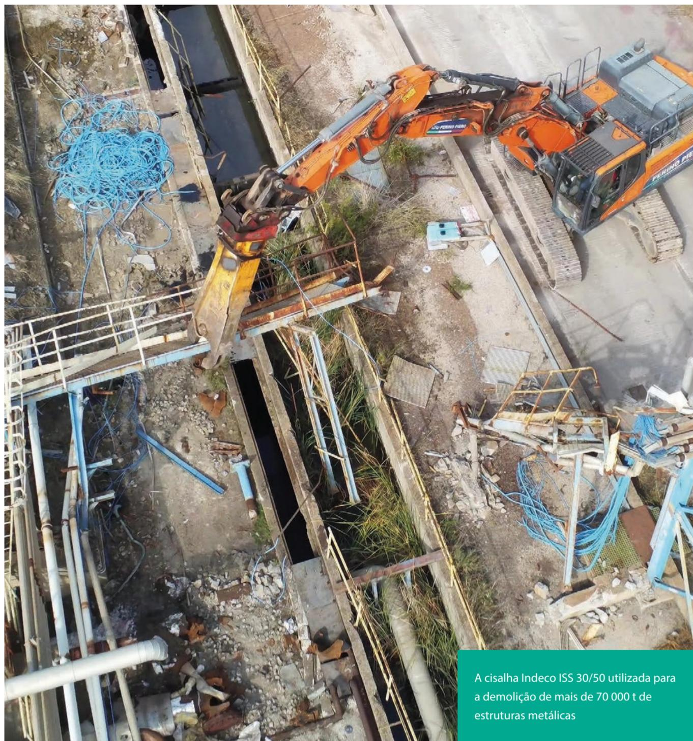
A cisalha Indeco ISS 30/50 utilizada para a demolição de mais de 70 000 t de estruturas metálicas
