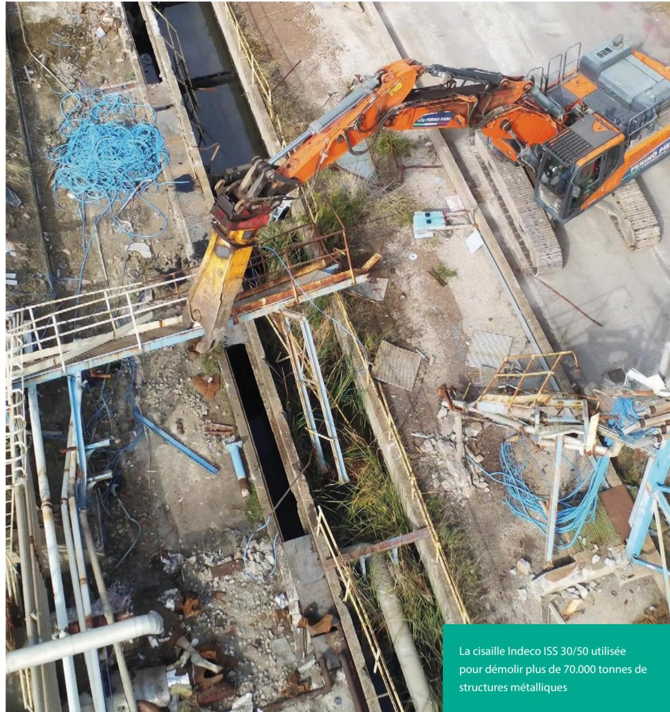
La cisaille Indeco ISS 30/50 utilisée pour démolir plus de 70.000 tonnes de structures métalliques
