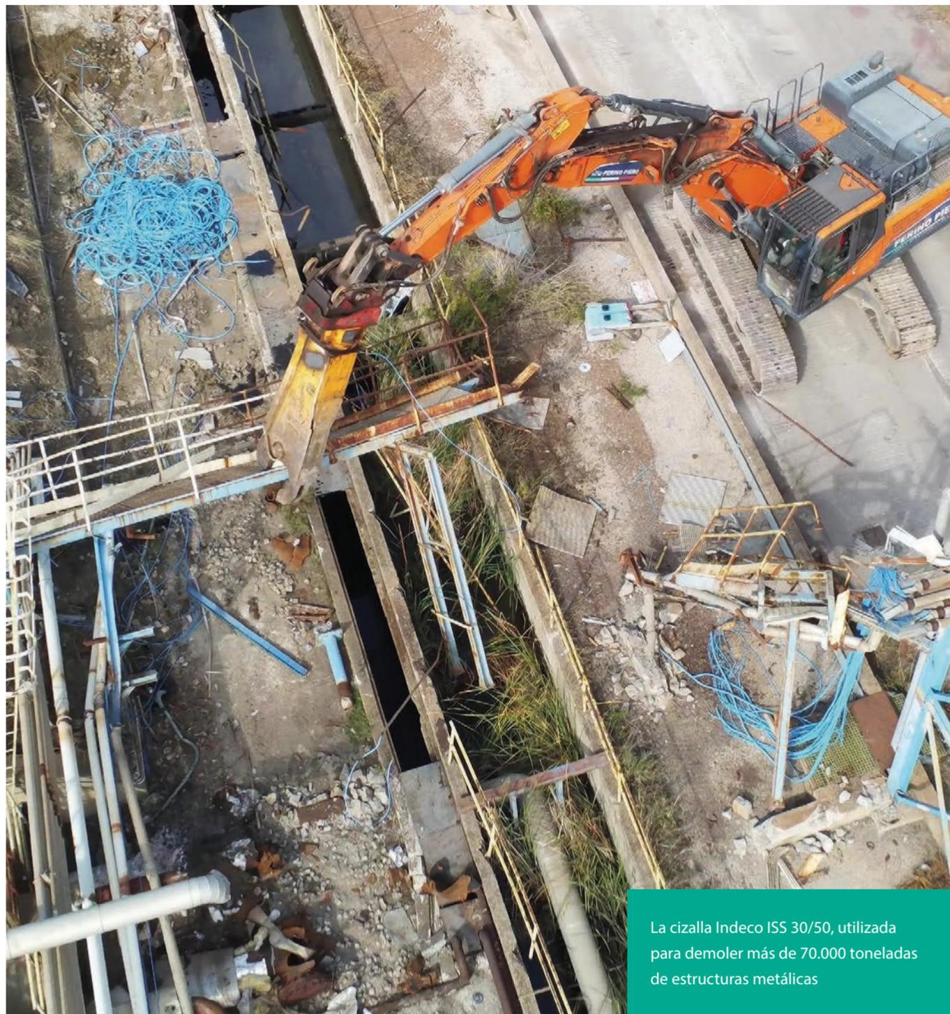
La cizalla Indeco ISS 30/50, utilizada para demoler más de 70.000 toneladas de estructuras metálicas
