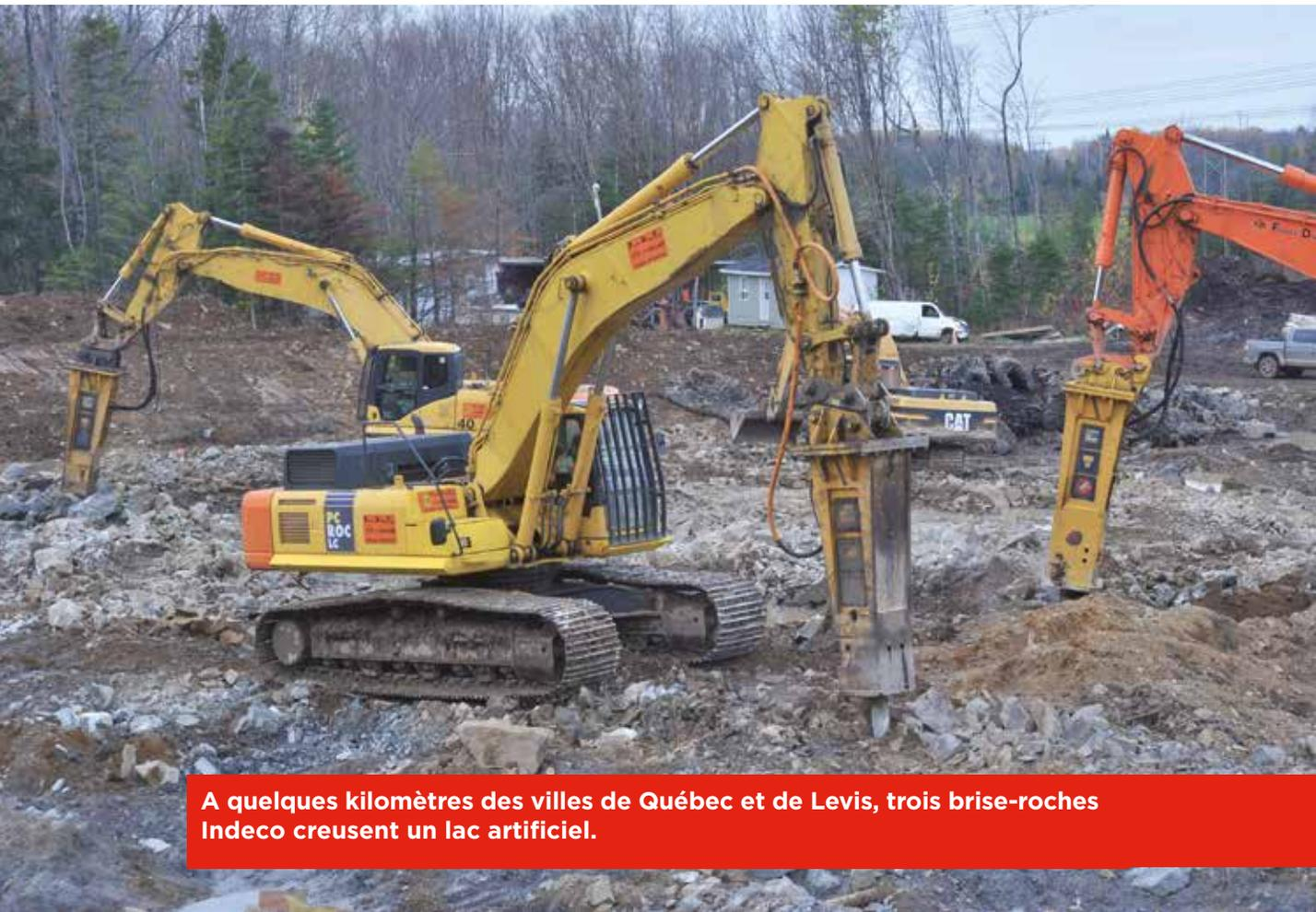
**A quelques kilomètres des villes de Québec et de Lévis, trois brise-roches Indeco creusent un lac artificiel.**
