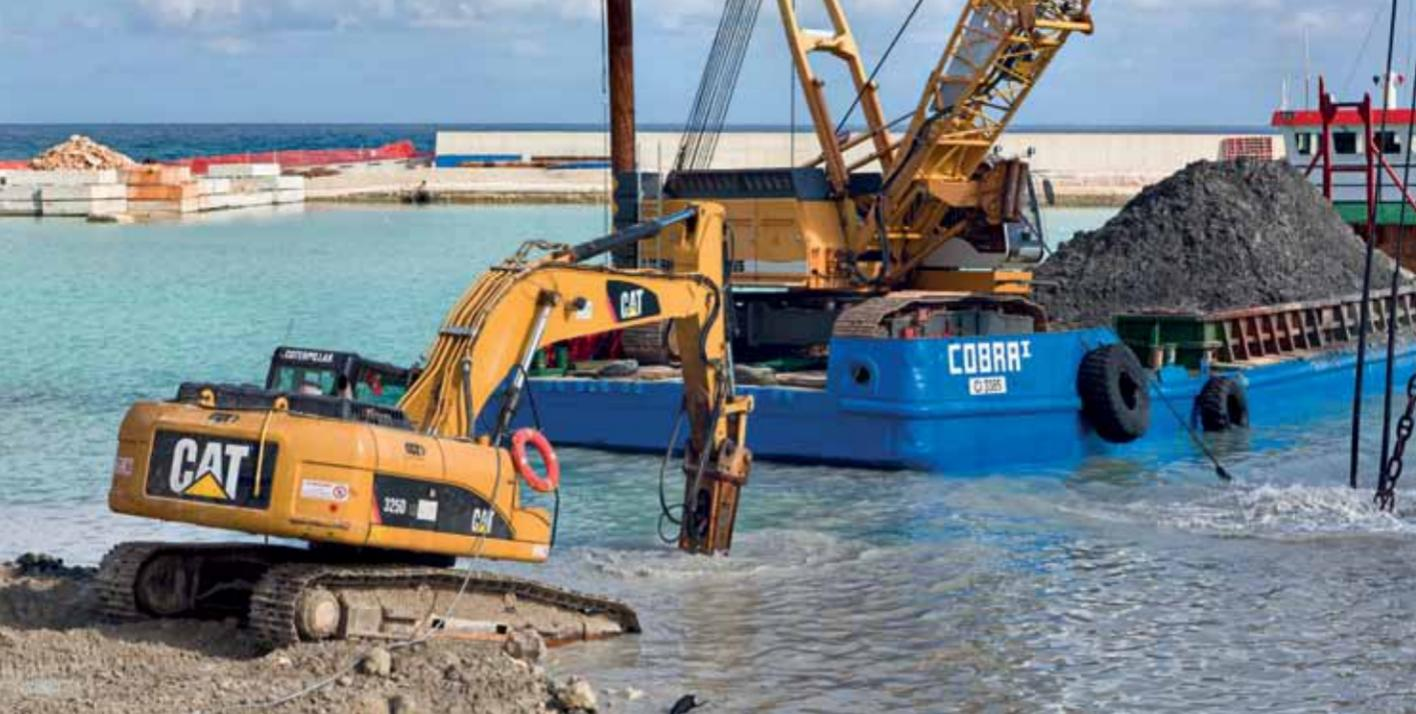
eine erste Abtragung der mittelfeinen Sandschicht vor; diese Arbeiten werden im gesamten Hafenbecken vorgenommen, um die vorgesehenen Höhen des Fahrwassers zu erreichen. Da das ausgebaggerte Material überwiegend aus Kalk besteht, kann es nach einer Zwischenlagerung auf dem Festland in einem Bereich, der später als Parkplatz genutzt werden soll, zum größten Teil als Auffüllmaterial beim Bau der vorgesehenen neuen Infrastrukturen (Kais, Molen) wiederverwendet werden.
