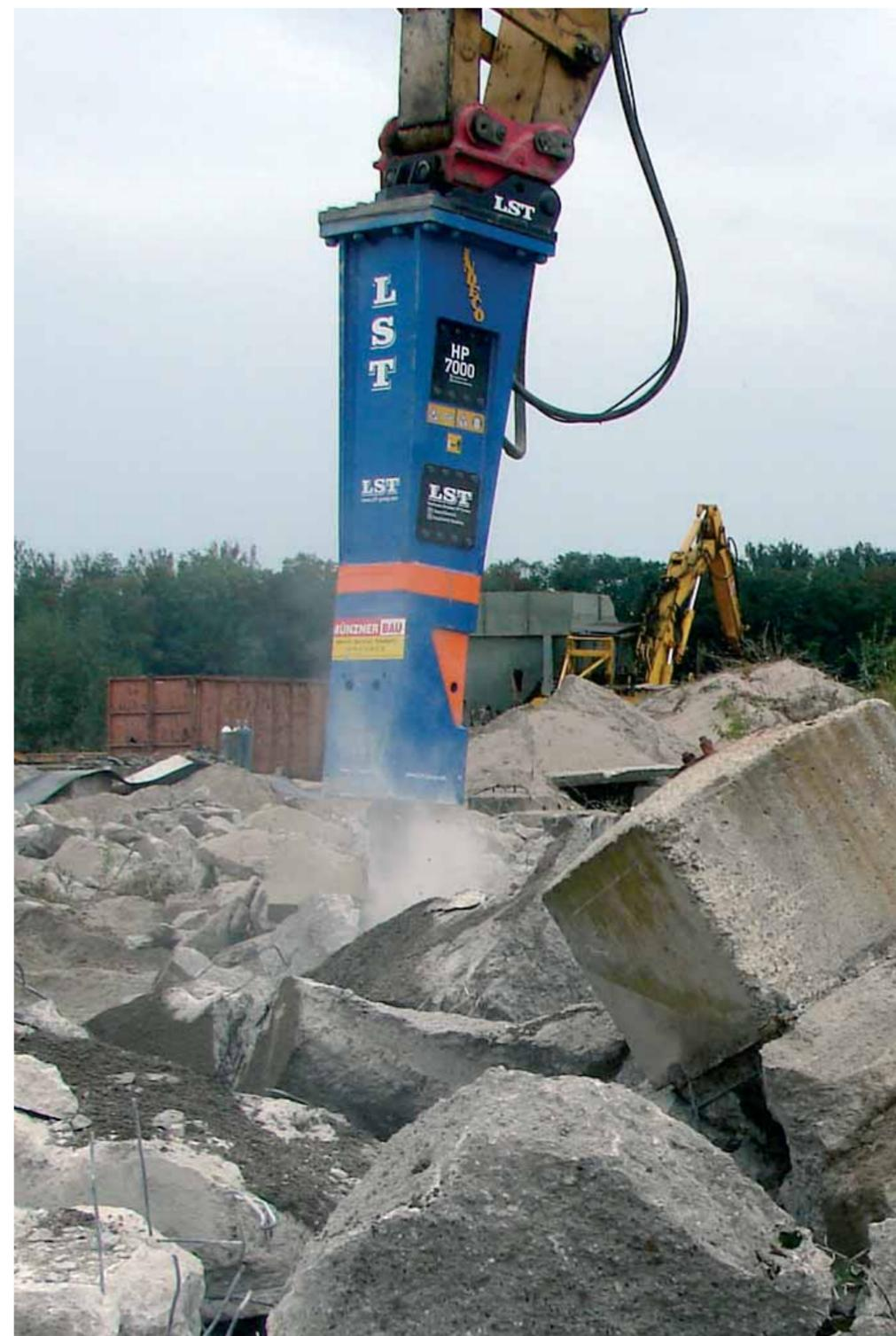
Se debía demoler y retirar un total aproximado de 1.500 m<sup>3</sup> de hormigón reforzado en menos de 7 días. “Gracias al HP 7000, con una herramienta de 180 mm. de diámetro y la regulación automática del golpe, se pudo superar este desafío con una sola excavadora”.
