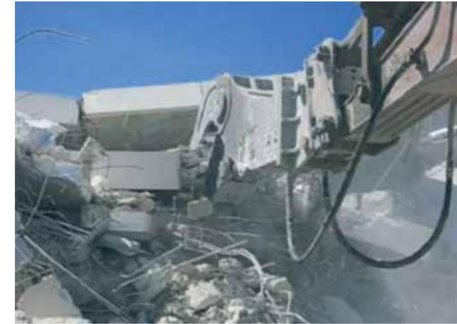
garantizar los máximos niveles de seguridad. Finalmente, el edificio Quistelli fue demolido por una excavadora sobre orugas "PMI 980 Superlong Demolition", máquina de 140 toneladas de peso con un motor endotérmico de 14.000 c.c. de cilindrada, de los que sólo existen 4 unidades en el mundo, dos de ellas en Europa.
