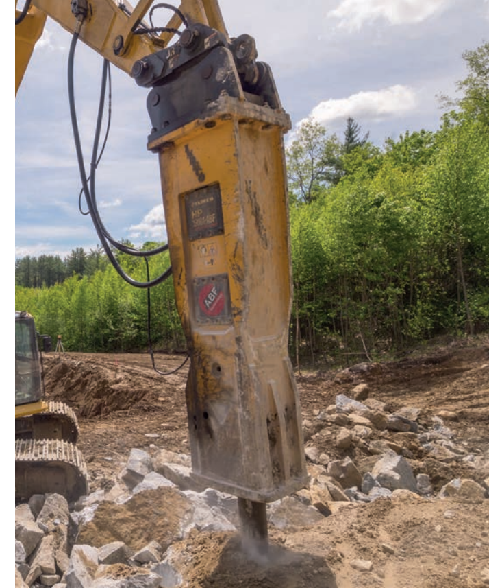
L'HP 13001 (HP 9000) all'opera su un banco di granito blu compatto di notevole durezza
