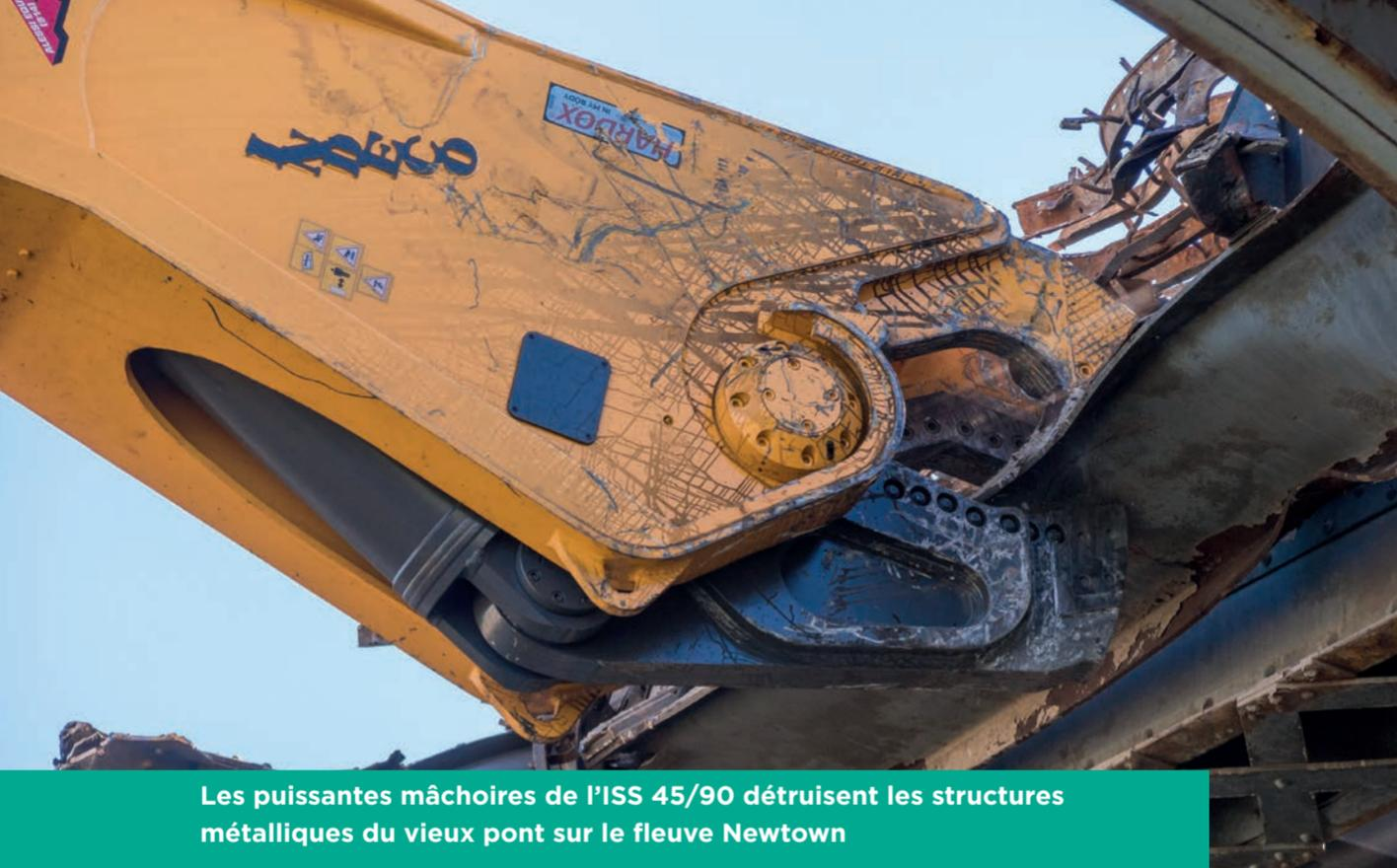
Les puissantes mâchoires de l'ISS 45/90 détruisent les structures métalliques du vieux pont sur le fleuve Newtown
