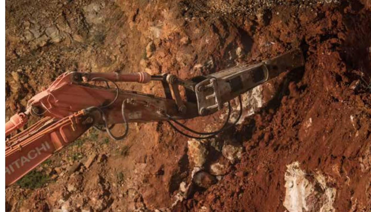
und zwei HP 7000. Die Tagesproduktionen lagen an den ca. 800 Arbeitstagen bei ca. 750 m<sup>3</sup> für den HP 9000 und 550 m<sup>3</sup> für den HP 7000, wobei die erwartete Leistungsfähigkeit erreicht wurde. Dank der Leistungen der Hämmer konnten die Vertragsbedingungen und die Fristen für die Ausführung der Aushubarbeiten eingehalten werden. An der Kreuzung mit der vorhandenen Trasse war eine Unterbrechung des nächtlichen Bahnbetriebs notwendig, während der in
