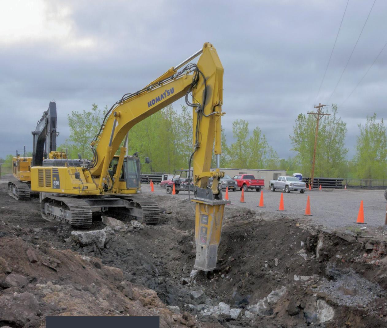
**Para a demolição, a LPCiminelli usou cinco martelos Indeco (um HP 8000, dois HP 13001 e um HP 16000).**
