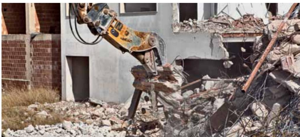
Nell'ambito del programma di riqualificazione delle periferie e sistemazione a verde il Comune di Turi ha fatto demolire un vecchio edificio in cui aveva avuto sede un ospedale. La demolizione della costruzione ha previsto l'abbattimento di circa 4000 m<sup>3</sup> di materiale. L'IFP 1000 Indeco lavora alla separazione in sito del materiale demolito dal tondino che arma il cemento.
