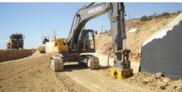
A empresa libanesa Hourieh Enterprises usa com satisfação desde 2009 um compactador Indeco IHC 200, montado em um Volvo 2006. O equipamento é usado para a compactação de pistas de autoestradas e rodovias, para remover fossos e poços.
