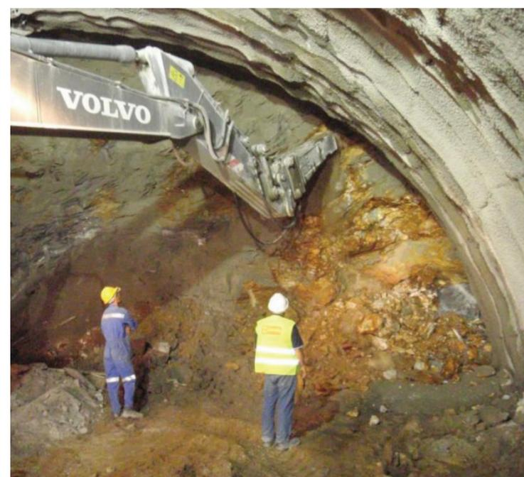
Até que limite se pode aproveitar a capacidade produtiva de um martelo Indeco? Tentou-se descobrir isso em Portugal onde uma HP 2500 tem trabalhado em condições e com ritmos realmente extremos. O martelo, adquirido no centro de locação VolvoRent foi usado por um cliente deles para a construção de um túnel rodoviário em tempos reduzidíssimos. Por este motivo ela foi utilizada em um trabalho de escavação contínuo, 24 horas por 24, enquanto os operadores se alternavam em diversos turnos.
