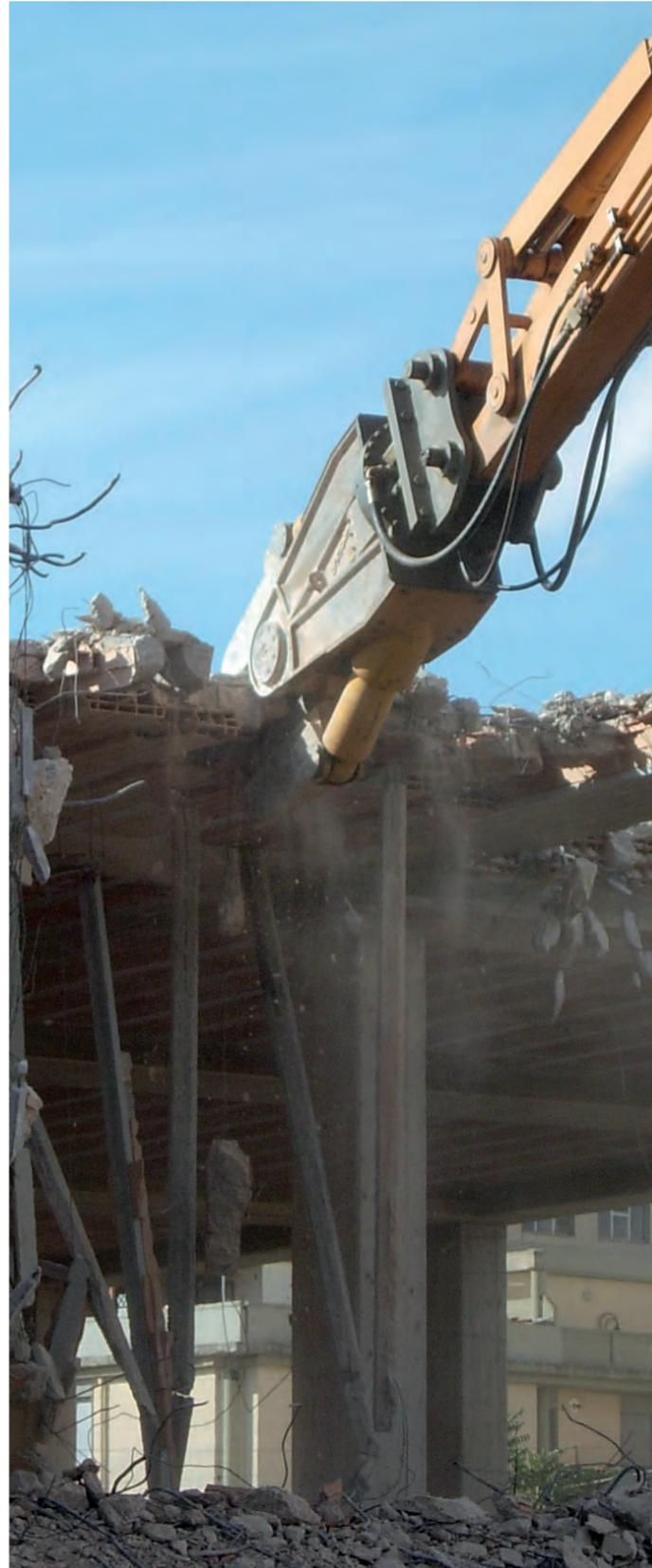
Rotación hidráulica continua a 360°, con válvula de protección, que permite una mejor demolición en todas las condiciones de trabajo y una extracción siempre optimizada de material a demoler
